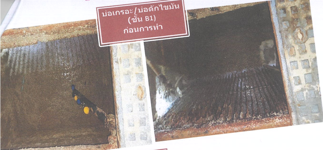
บ่อเกรอะ/บ่อดักไขมัน (ชั้น B1) ขณะกำลังทำ
